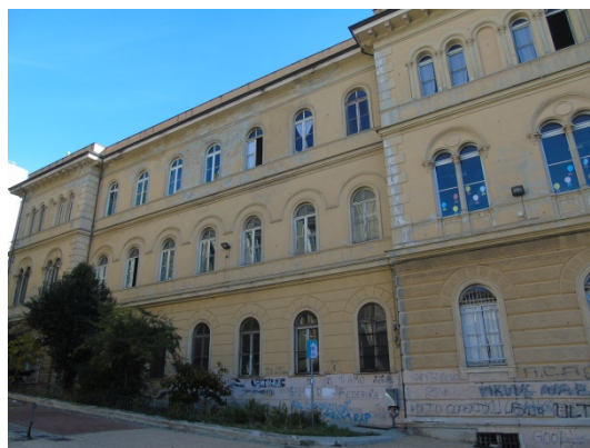
Figura 1.1 - Vista della facciata esposta a Ovest
