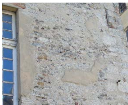
Figura 8.3 – Particolare muratura da isolare
